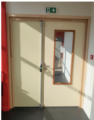
Localisation : Porte DAS sur circulation rez-de-chaussée et 1er étage
